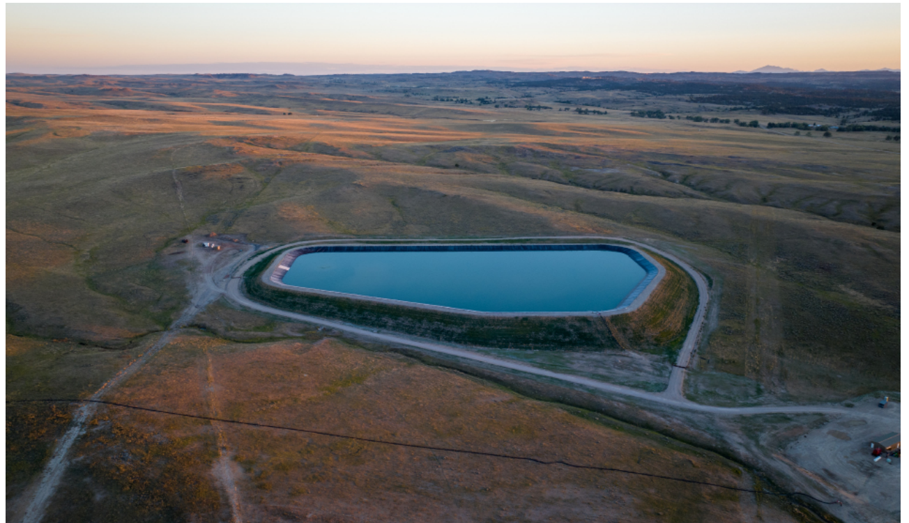
Wasservorhaltebecken in Wyoming
