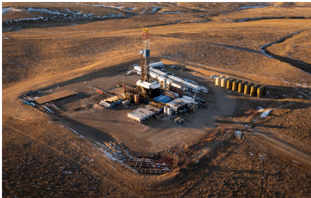
Bohrarbeiten von Bright Rock Energy Llc in Wyoming
