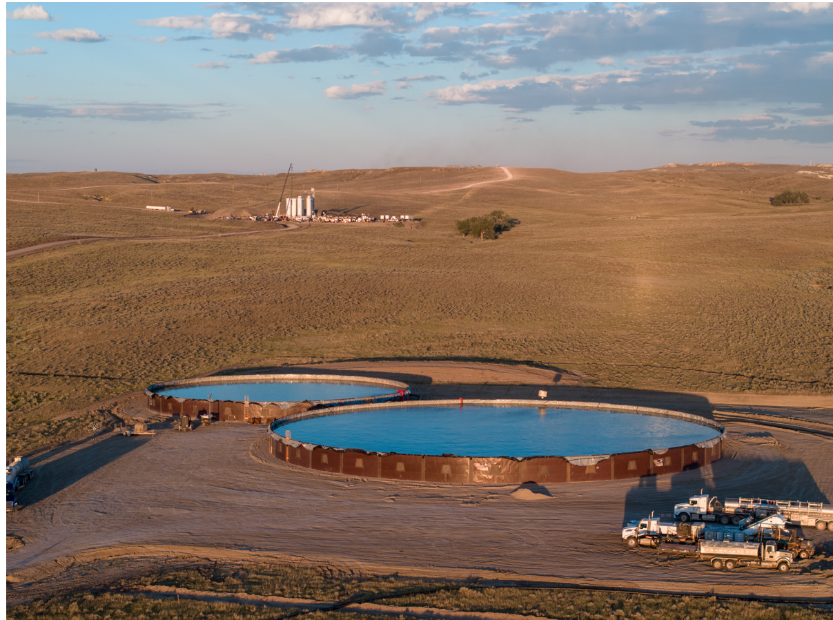
WASSERTANKS FÜR DIE FERTIGSTELLUNG DER BOHRUNGEN, WYOMING
