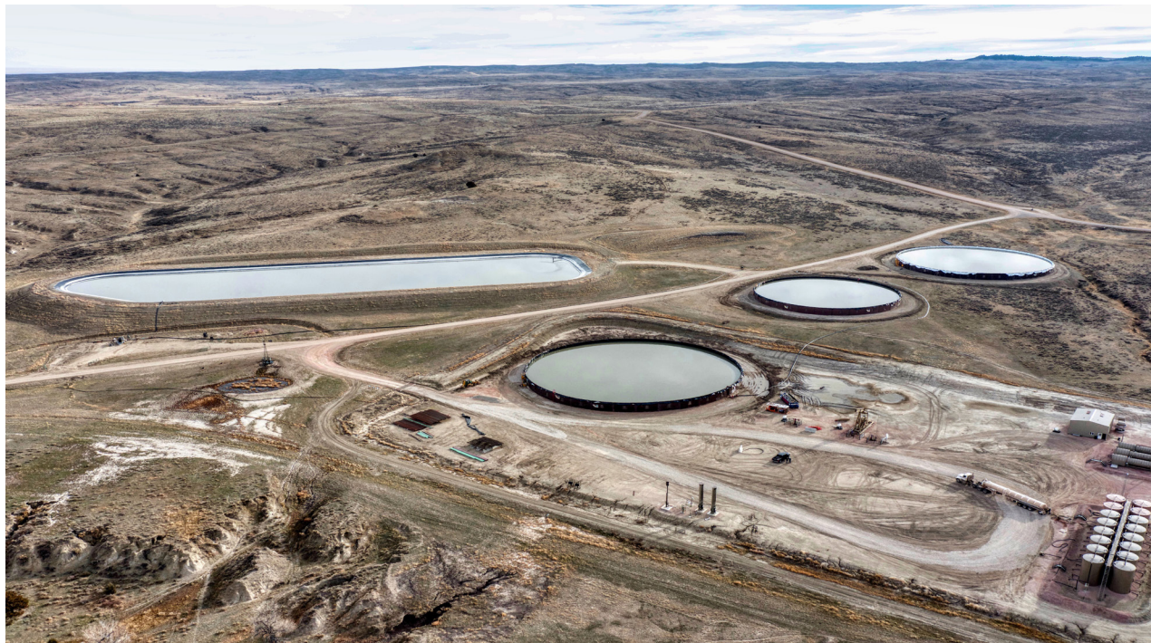
WASSERTANKS AUF CUB CREEKS BOHRPLATZ IN WYOMING, USA
