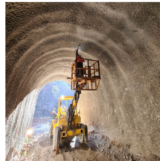
ZUGANGSSCHACHT „MONTY B PORTAL“, SANGDONG MINE, SÜDKOREA
