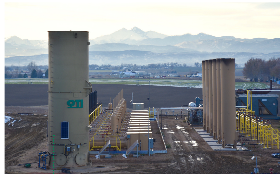
PRODUKTIONSANLAGEN AUF DEM MARKHAM-BOHRPLATZ
