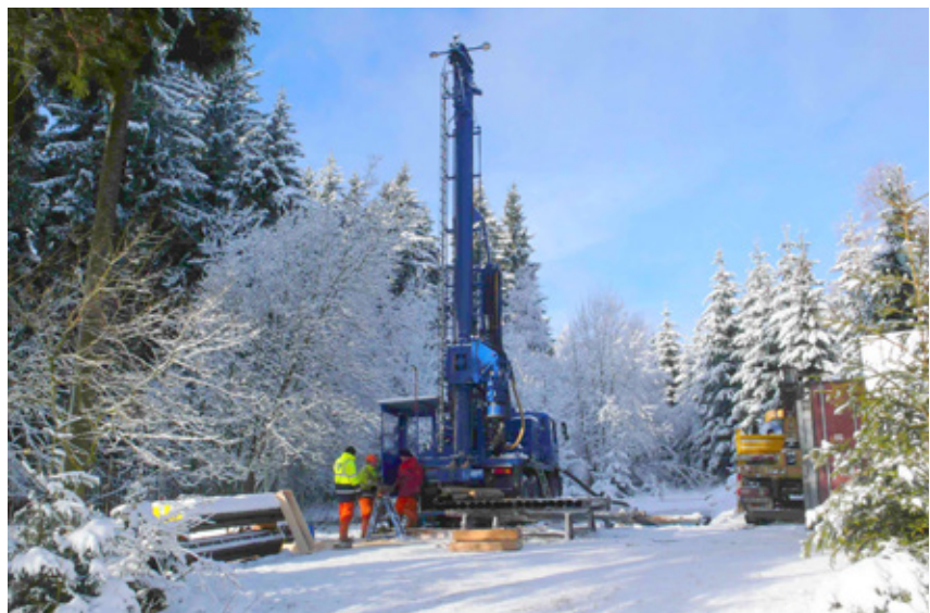
Bohrung der Sachsenzinn in Gottesberg
